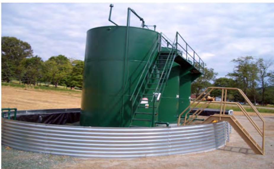
Afbeelding 2.8. Opslag voor productiewater en condensaat [ref. 2.]
