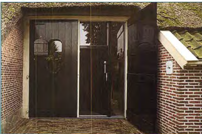
Verbouw van het oorspronkelijke hoofdgebouw
