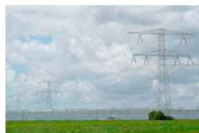
Afbeelding 9: Te amoveren 380 kV over kassen bij Rilland
