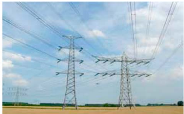
Afbeelding 2: 4 circuit 150 kV bij station Borssele
