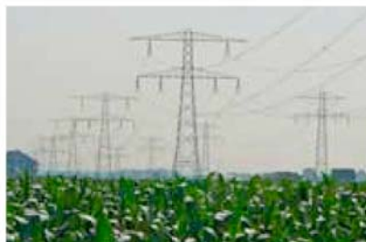
Afbeelding 14: Bestaande bundeling 150 kV en 380 kV ten westen van Geertruidenberg
