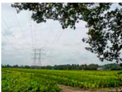
Afbeelding 19: Huidige 380 kV tussen Geertruidenberg en Tilburg
