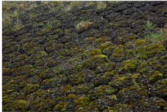
Een steenbekleding van basaltblokken
