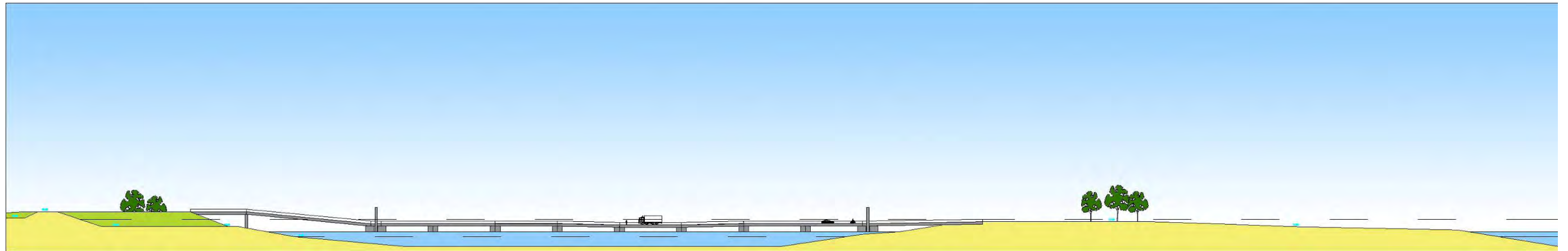
Aanzicht brug Landtong West
