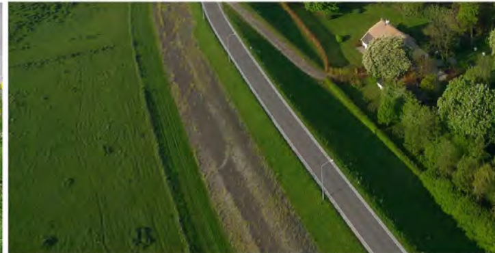
Een mengvorm, waarin alleen de voet van de dijk met steen is bekleed
