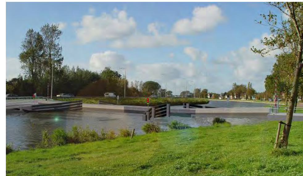
Referentiebeeld Vlotbrug Geestmerambacht
