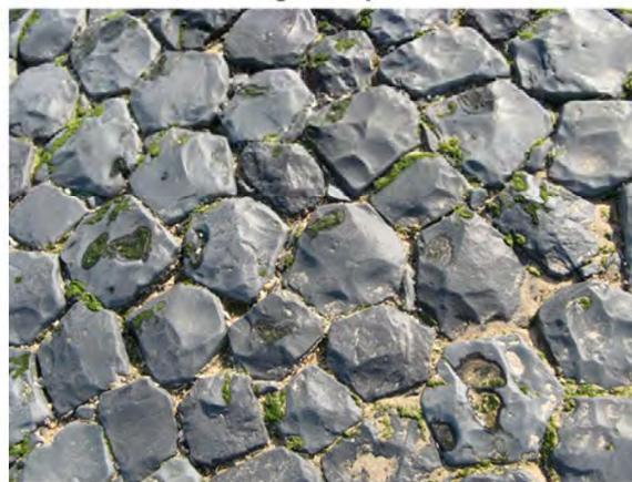
Zetsteen in de vorm van blokken basalt
