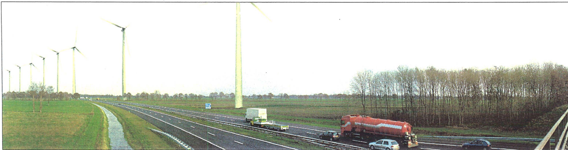
Zicht over de A28 in noordelijke richting vanaf viaduct bij de Lichtmis
