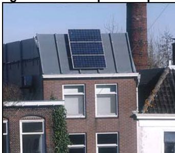
figuur 10: zonnepaneel op Delfts dak
