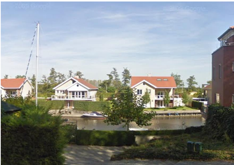
Figuur 5.2.4 Negen woningen aan de Oosthavendijk kunnen op de onderste woonlaag ca. 10 cm water in de woning krijgen tijdens waterberging.
