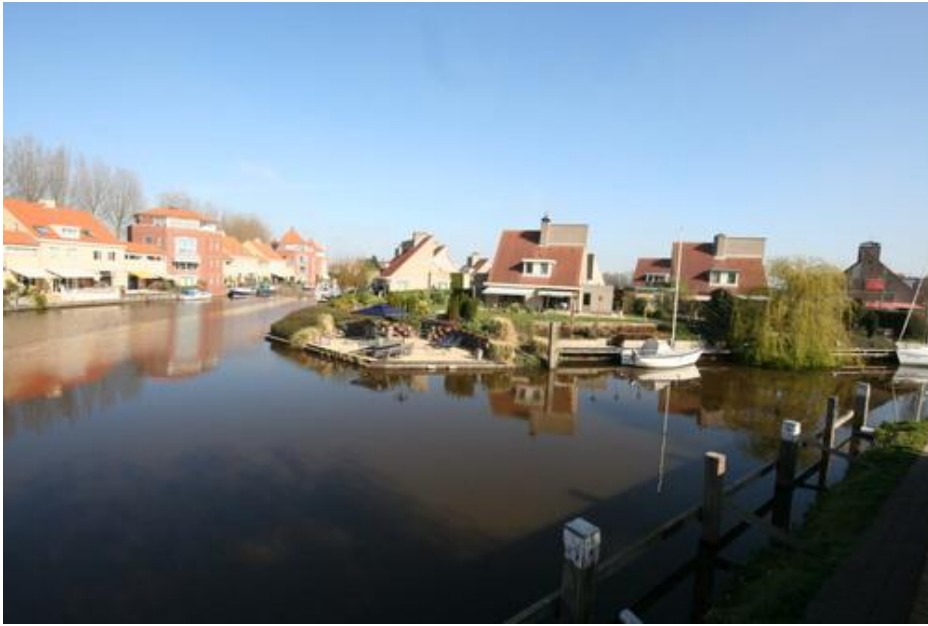
Figuur 5.2.3 Ruim 20 woningen/appartementen aan de Westhavendijk (aan linkerkant de foto) kunnen op de onderste woonlaag tot ruim 40 cm water in de woning krijgen tijdens waterberging (de woningen rechts op de foto – op het Eiland van Nassau - krijgen geen water binnen; die woningen liggen hoog genoeg).
