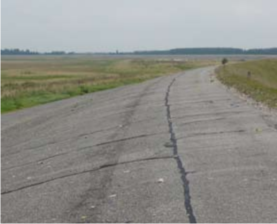
Asfaltdijk op de oever van Flakkee
