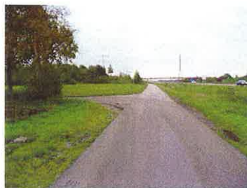
Foto 6: Noorder Kanaalweg (zuid)
