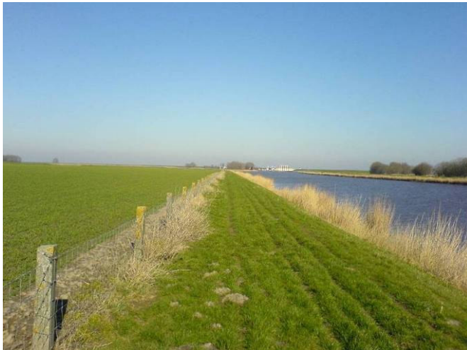
Opgehoogde landbouwgronden met onderhoudspad waterschap langs Benedenloop Westerwoldse Aa
