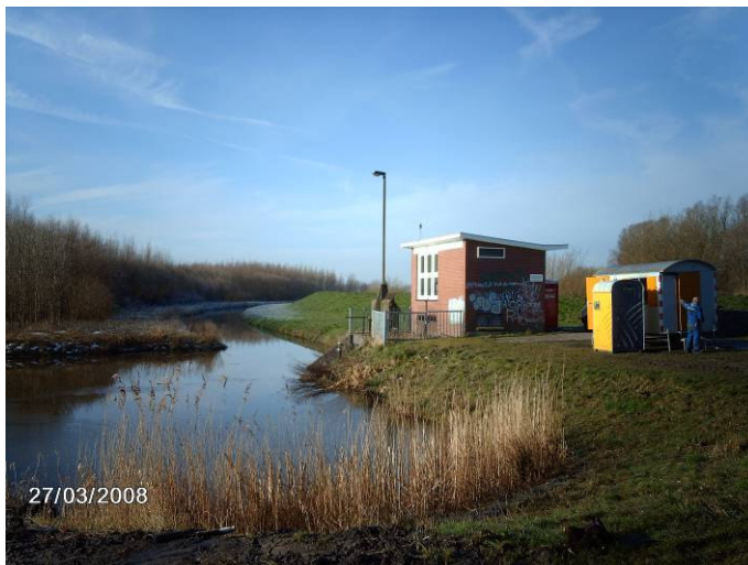
Bestaand gemaal Booneschans
