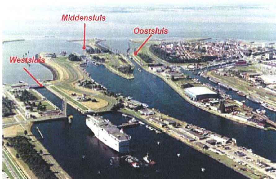
Figuur 2: Overzicht Sluisencomplex Terneuzen
