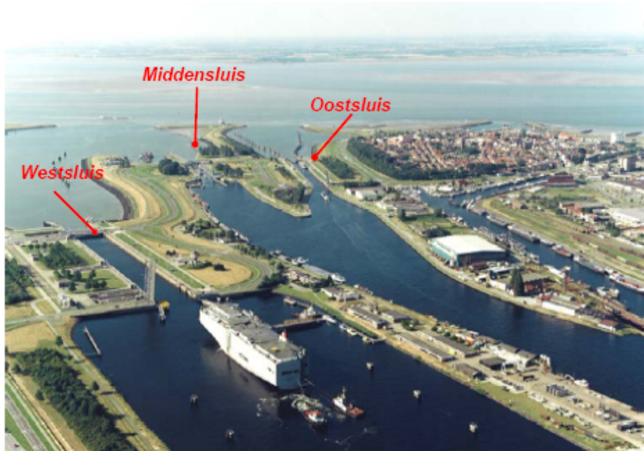
Figuur 2: Overzicht Sluizencomplex Terneuzen
