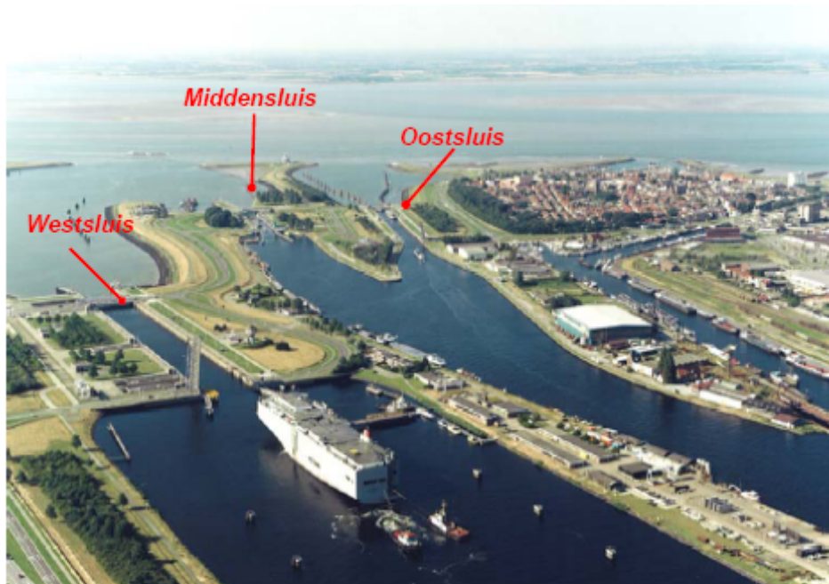
Figuur 2: Overzicht Sluizencomplex Terneuzen
