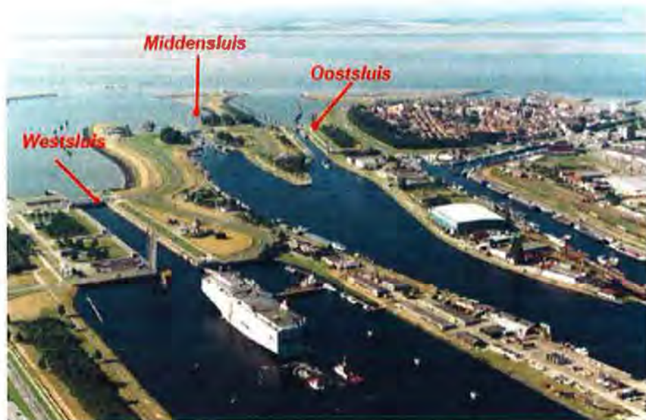
Figuur 2: Overzicht Sluizencomplex Terneuzen
