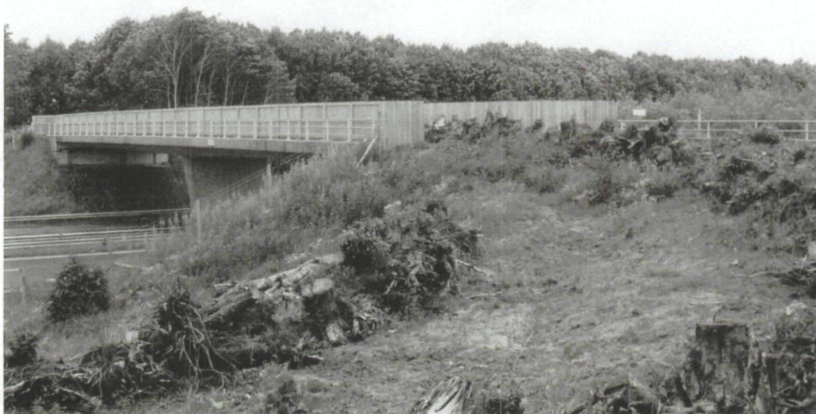
Foto 1: A7/Mienschceer. Viaduct locale weg in combinatie met een ecostrook.
