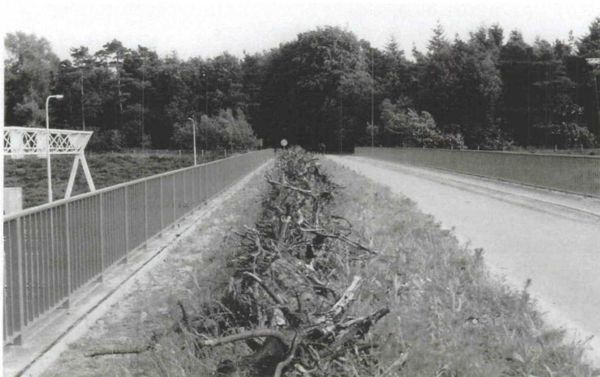
Foto 3: A28/Wallenburg. Viaduct toegangsweg tot manege in combinatie met een ecostrook.
