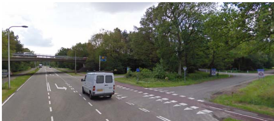
Balkerweg met rechts de oprit N48 en de Emslandweg
