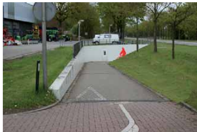
FIETSTUNNEL MET FLAUW TALUD IN BINNENBOCHT TOERIT. PASSANTEN ZIJN AL ZICHTBAAR VOOR HET PASSEREN VAN DE BOCHT.
