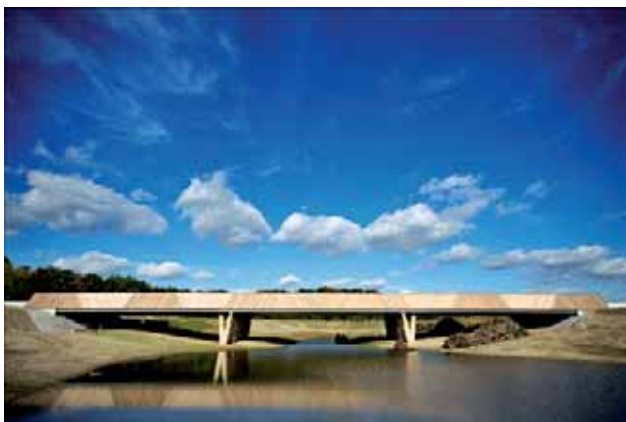
VOORBEELD VAN EEN VERWIJZING NAAR DE OMGEVING IN HET KUNSTWERK (ECODUCT ELST)
