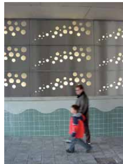
WANDAFWERKING TUNNEL ZWEEDESESTRAAT IN DEVENTER. DE VANDALISME BESTENDIGE WANDAFWERKING MET GEÏNTEGREERDE VERLICHTING VERGROOT HET GEVOEL VAN SOCIALE VEILIGHEID.
