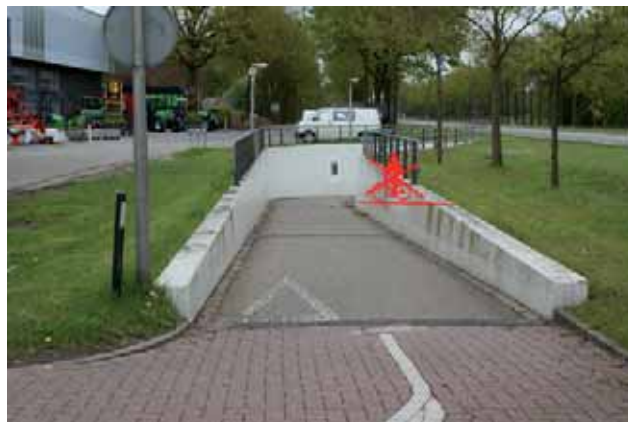
FIETSTUNNEL MET KEERWAND IN BINNENBOCHT TOERIT. PASSANTEN ZIJN PAS ZICHTBAAR NA HET PASSEREN VAN DE BOCHT.
