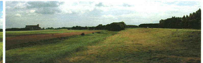
opgave: verleggen van de Deltadijk
