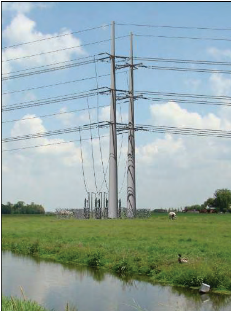
Figuur 3.14 Impressie van opstijgpunt 150 kV behorend bij een Wintrackmast
