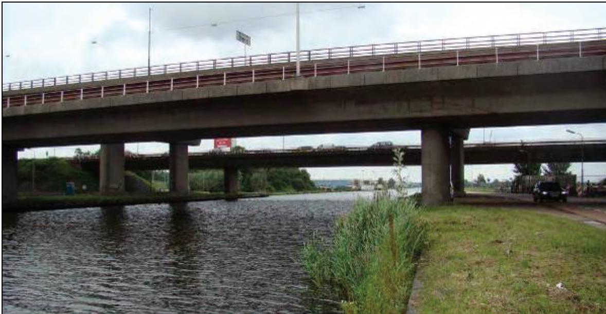
Figuur 4.19 De knoop rondom het Rottepolderplein met de Kruising van de Ringvaart van de Haarlemmermeer en de hooggelegen A9
