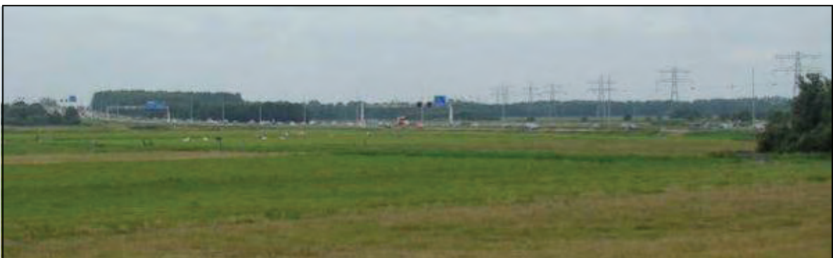
Figuur 4.18 De infrastructuurlijnen van de A9 en de huidige 150 kV verbinding drukken een duidelijk stempel op het relatief open veenweidegebied van de Vereenigde Binnenvlakte, foto genomen in noordelijke richting
