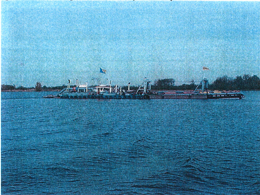
figuur 4.3: zandwinningswerkzaamheden op de Reeuwijkse Plassen
