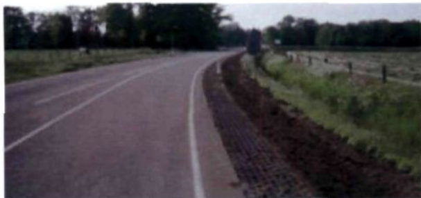
Figuur 6.1-3 Semi-verharde berm, een maatregel uit het KEM-pakket
