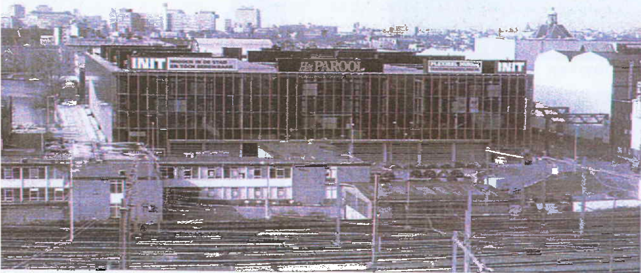
INIT gebouw Amsterdam
