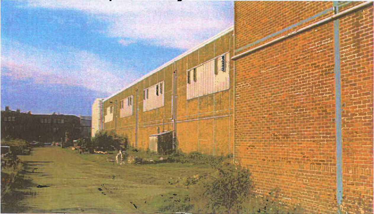
De ketelfabriek aan de kant van de Lampsinsstraat. Op de voorgrond hal nummer 6, geplaatst in 1952, daarachter de eerder gebouwde hallen.
