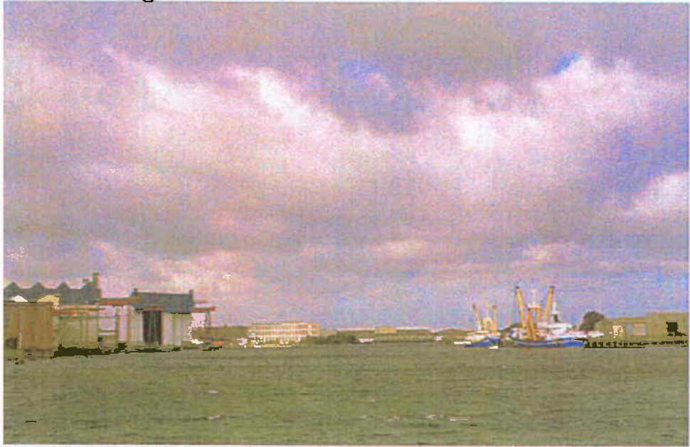
Tussen de timmerfabriek (het betonnen gebouw op de achtergrond) en de beide schepen mondt het verbindingskanaal uit in de Dokhaven.
