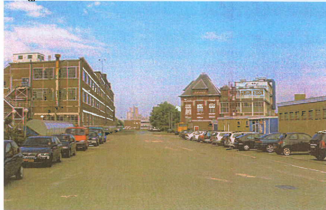
De Aagje Dekenstraat met links de machinefabriek en rechts het hoofdkantoor
