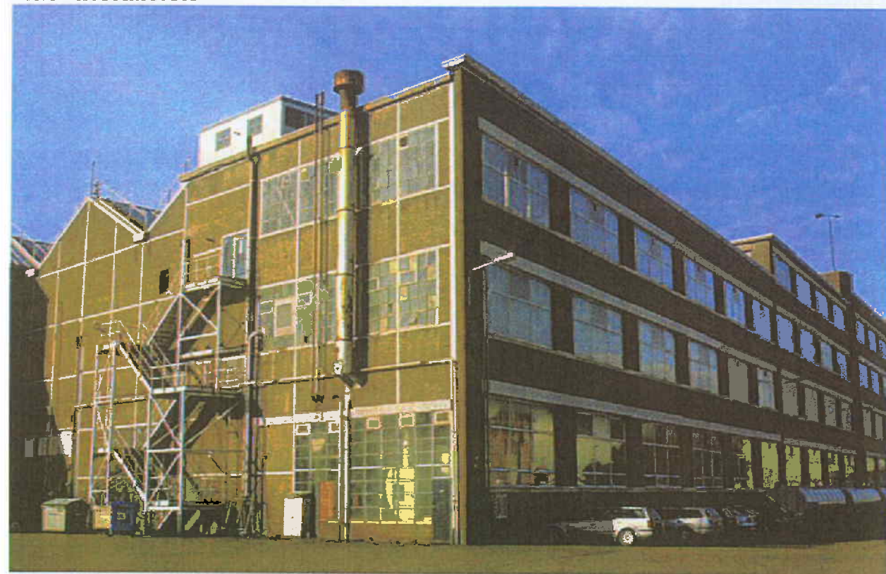
De machinefabriek gezien vanaf de Aagje Dekenstraat. Dit gedeelte stamt uit 1953, de oudste delen van de fabriek zijn gebouwd in 1913, 1916, 1919 en 1939.
