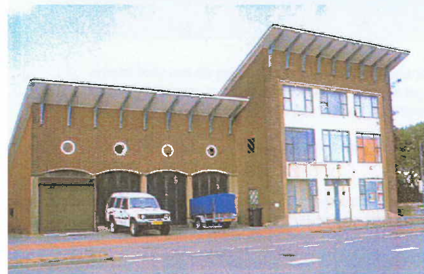
Woning en garages op de hoek van de Koningsweg en de Paul Krugerweg.
