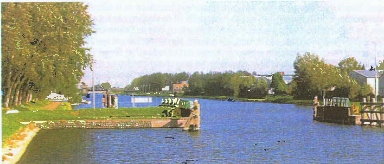
De oude keersluis in het Kanaal door Walcheren.
