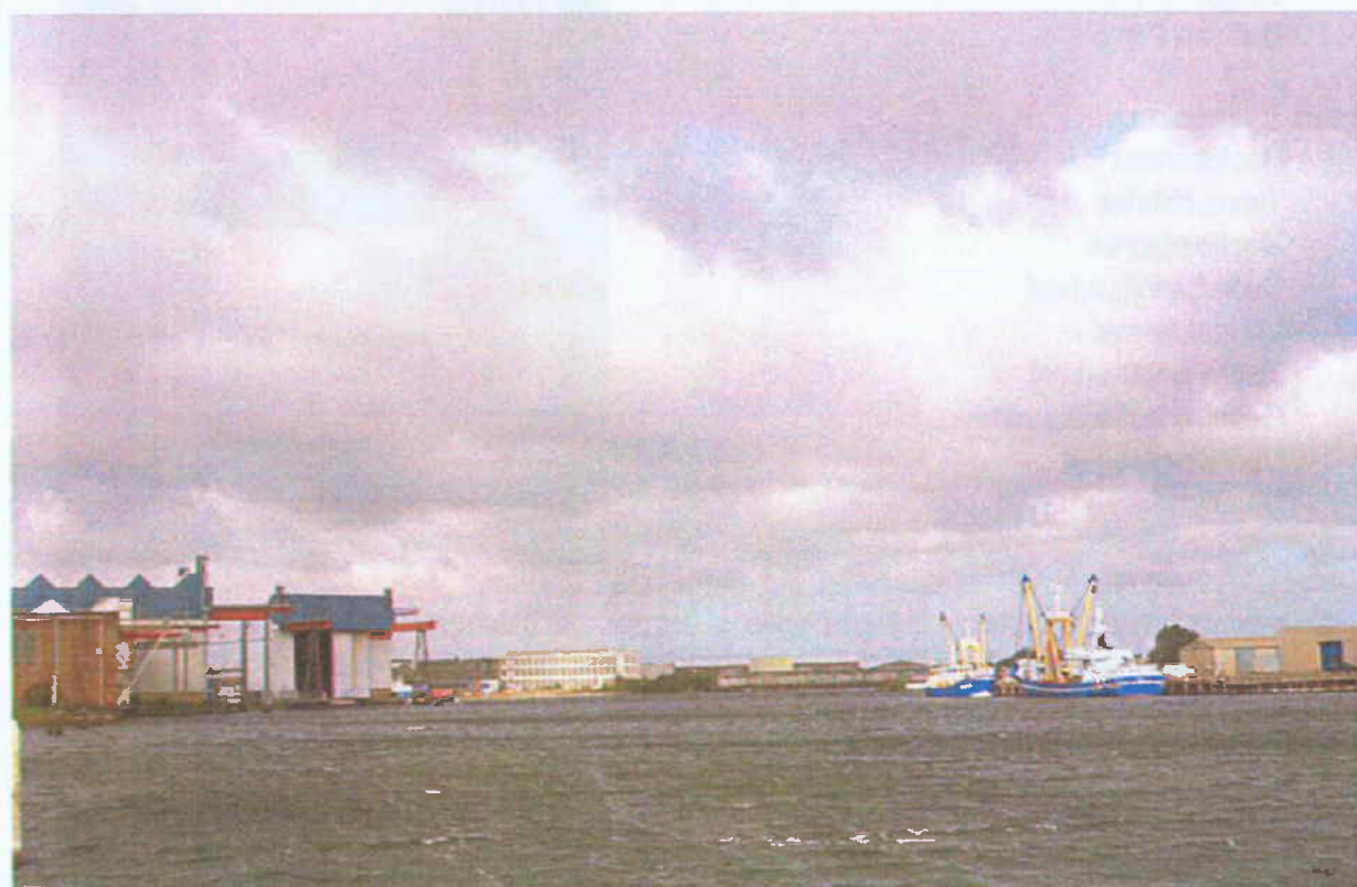
Uitzicht vanaf het Eiland op verschillende terreinen en gebouwen van De Schelde. De bedrijfsgebouwen links op de foto liggen op het Eiland; in het midden zien we de timmerfabriek en andere panden die onderdeel uitmaken van het te ontwikkelen gebied. De schepen liggen aangemeerd aan de kade aan de oostkant van het Kanaal door Walcheren.
