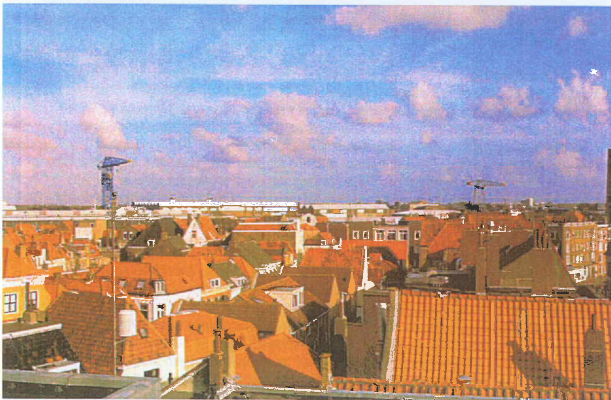
De kranen en gebouwen van De Schelde domineren het stadsbeeld van Vlissingen.
