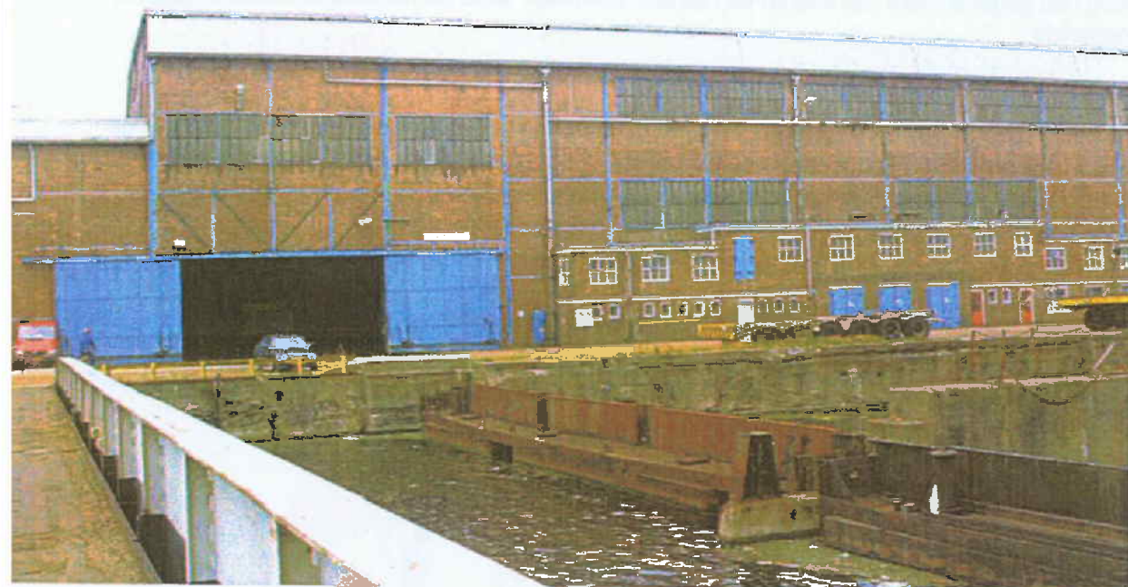
het oudste deel van de zware plaatwerkerij, een van de gebouwen rond de Dokhaven met duidelijke Scheldekenmerken: een groot bouwvolume en muren bestaande uit een stalen vakwerk, opgevuld met bakstenen.
