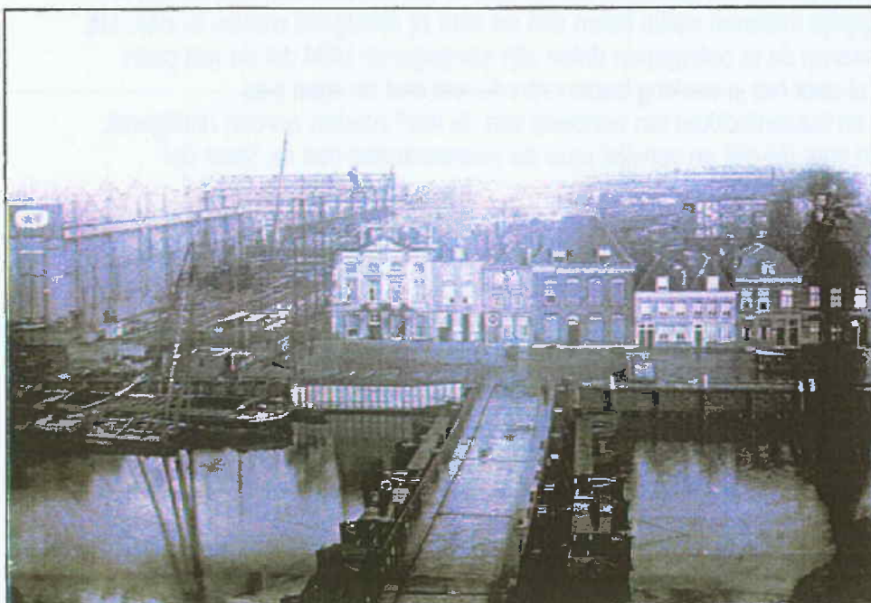
Afbraak en nieuwbouw gingen lange tijd hand in hand op het Scheldeterrein. Op de foto de bouw van de derde hal van de machinefabriek in 1919, waarbij het Huis met de Beelden nog net kon worden gespaard. Later zou dit toch worden gesloopt.
