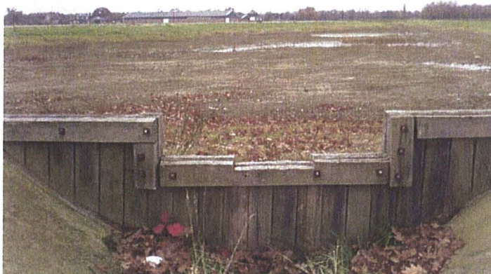
figuur 2-8 foto overstortdrempel bergingsvoorziening industrietrein Vorstengrafdonk
