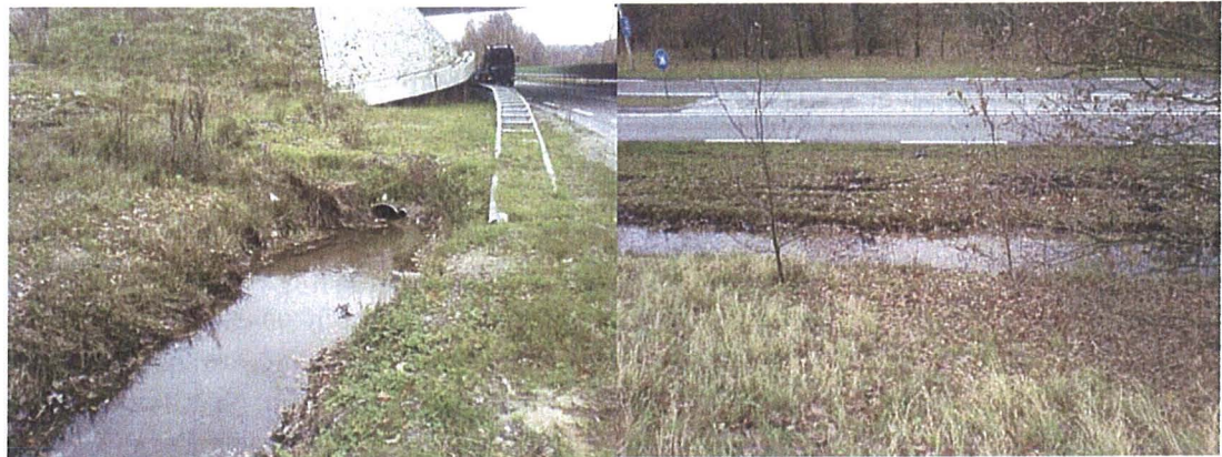
figuur 3-3 foto's van duiker onder de A50 en ten oosten van A50 aan de noordzijde van de N324
