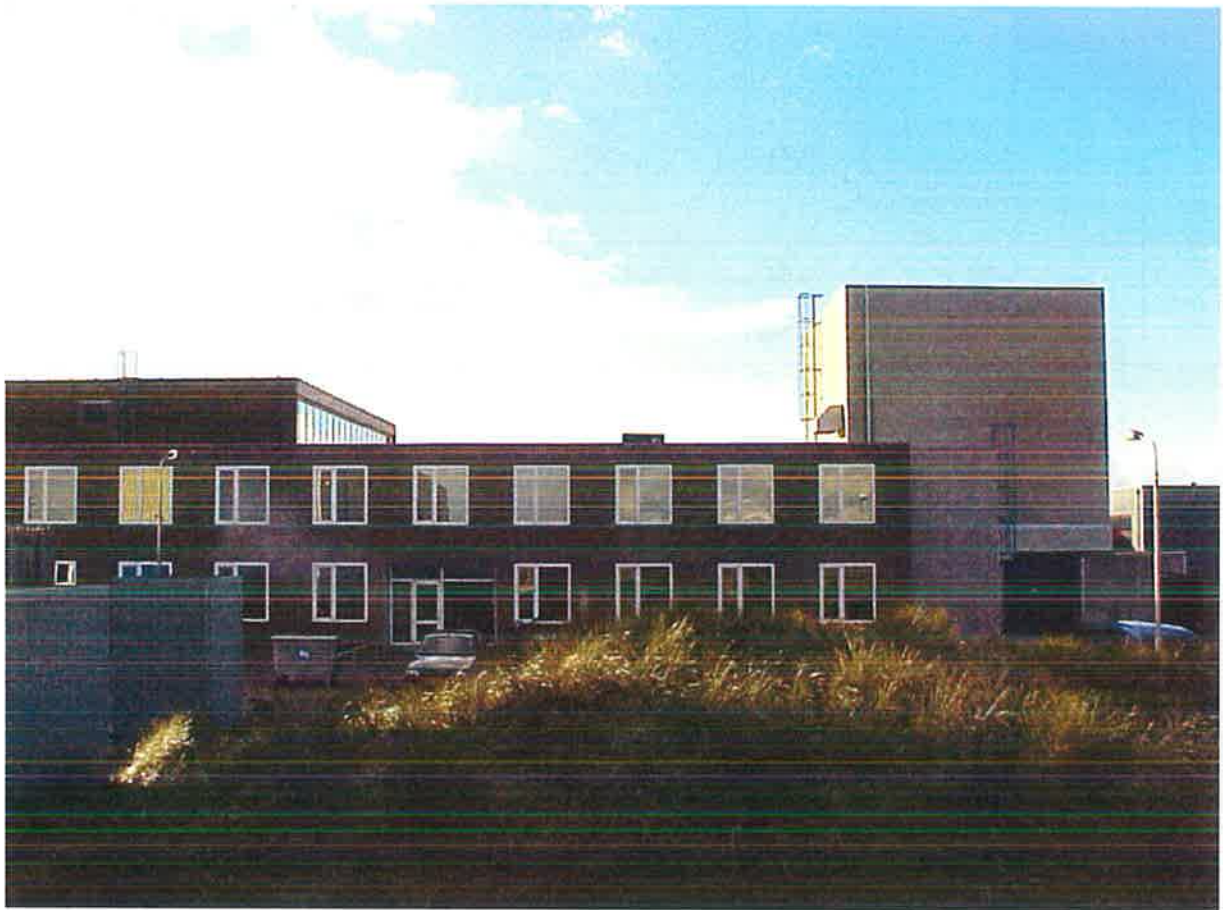
figuur 3 Gevelaanzicht Fermi-gebouw en STEK-hal
