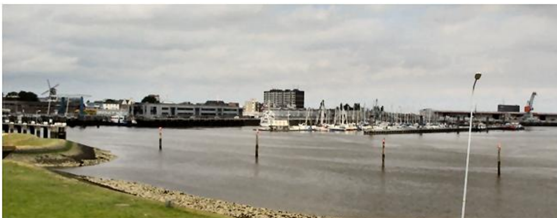
Figuur 1.1 overzicht haven richting centrum Delfzijl
