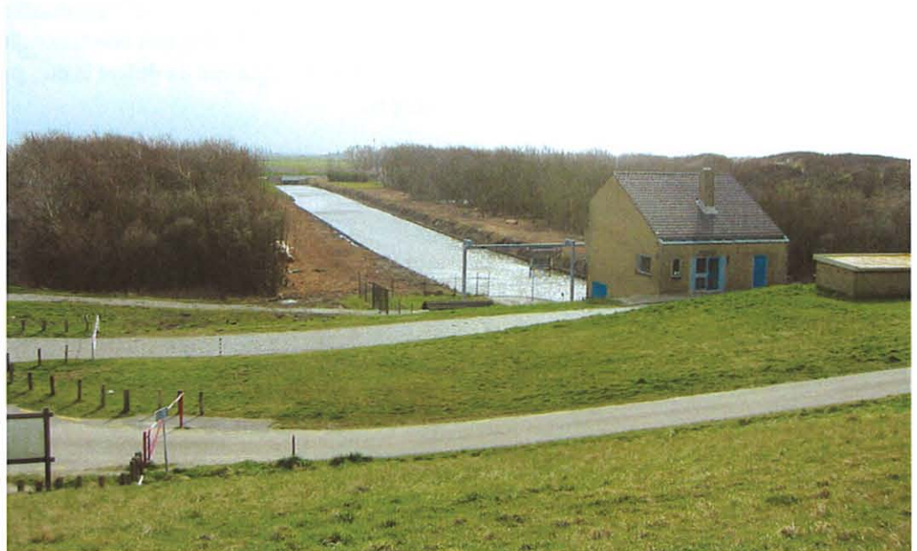
Gemaal Nieuwe Sluis
