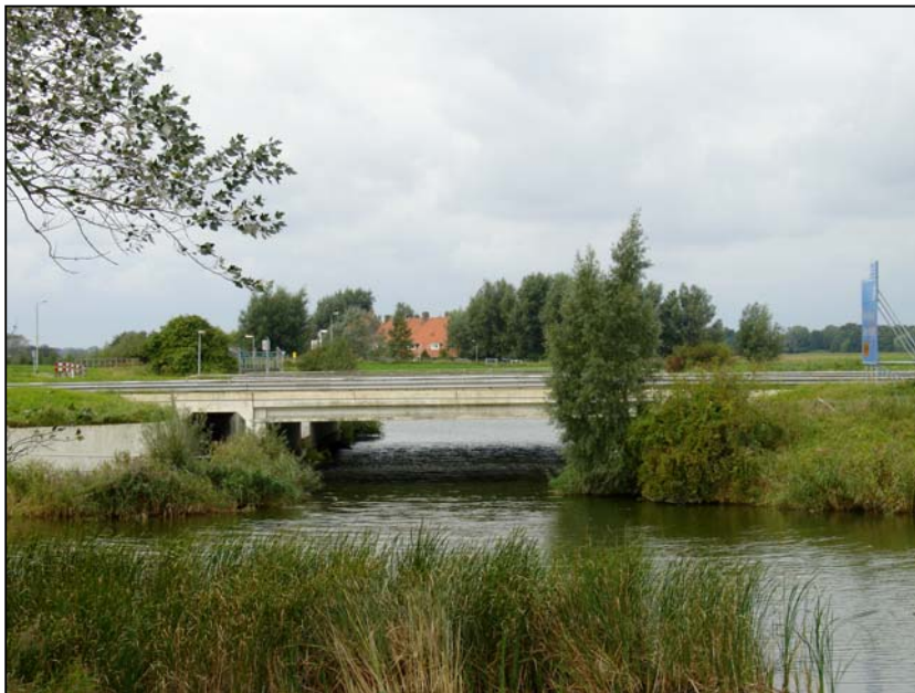
brug in plangebied
