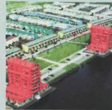
Almere Buiten 84 woningen / 3 woontorens
