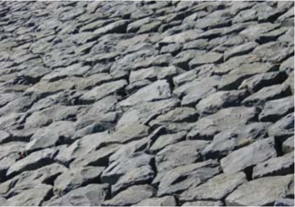
taluds bestaand uit basaltkeien
