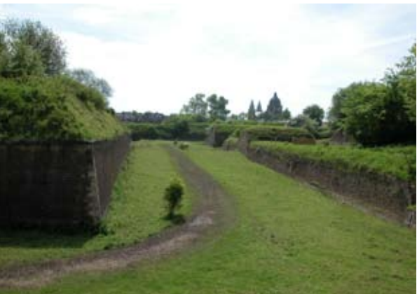
oude muren van het fort geven sfeer aan de openbare ruimte
