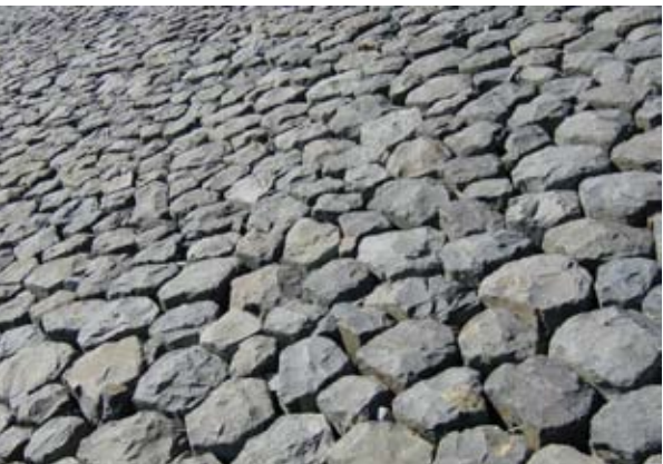
basaltkeien als oeververdediging
