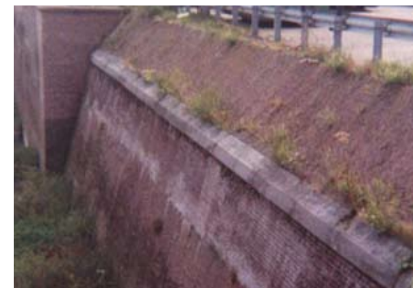
de muur van het fort Krayenhoff aan de Waal
