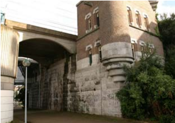
de onderdoorgang onder de spoorbrug
