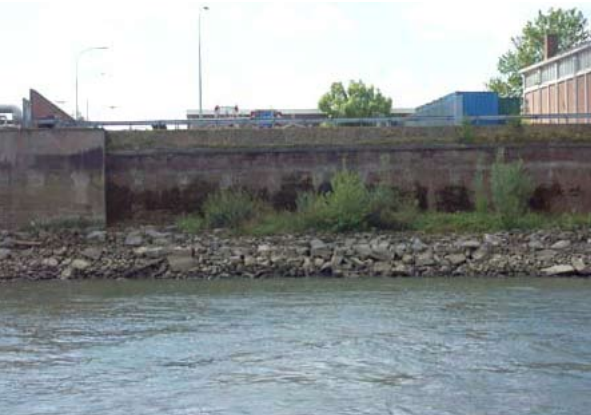
de muur van fort Krayenhoff aan de Waal
