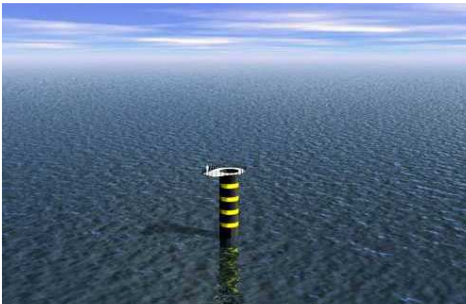
Figuur 4.18 Monopaal met transitiestuk geplaatst in zee
