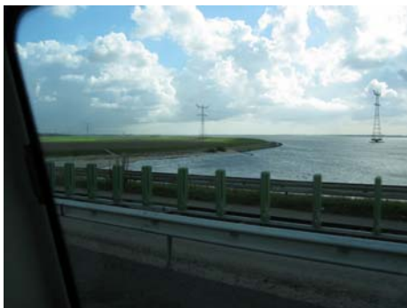
foto: Brug Ketelmeer
