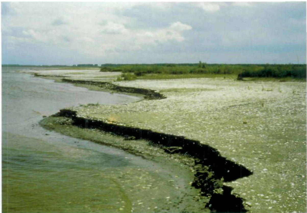
Foto 27 Door oevererosie zijn steilranden ontstaan.
