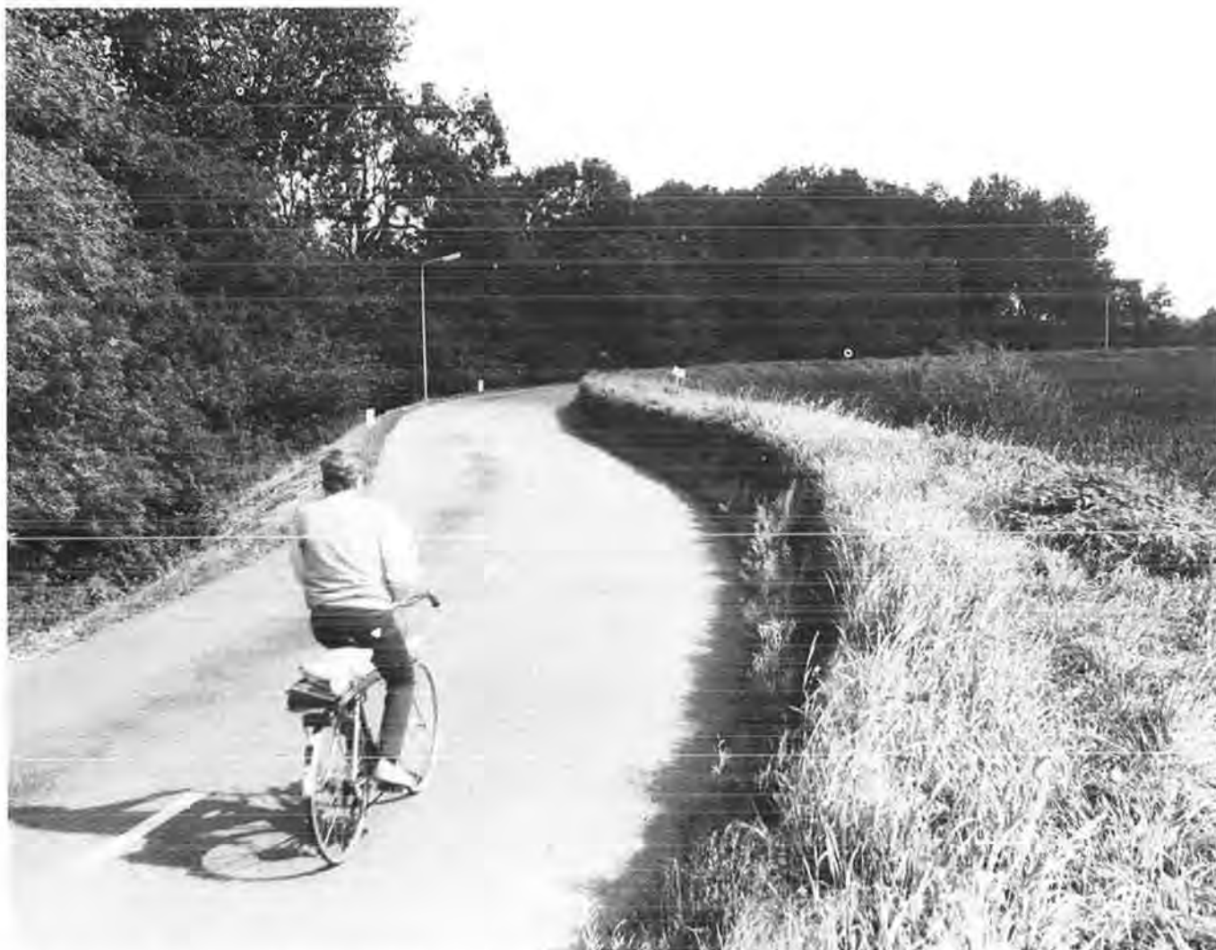
De dijk tussen Krimpen aan de Lek en Lekkerkerk ter hoogte van de Bakkerswaal. Rechts de Visscherplaat.
