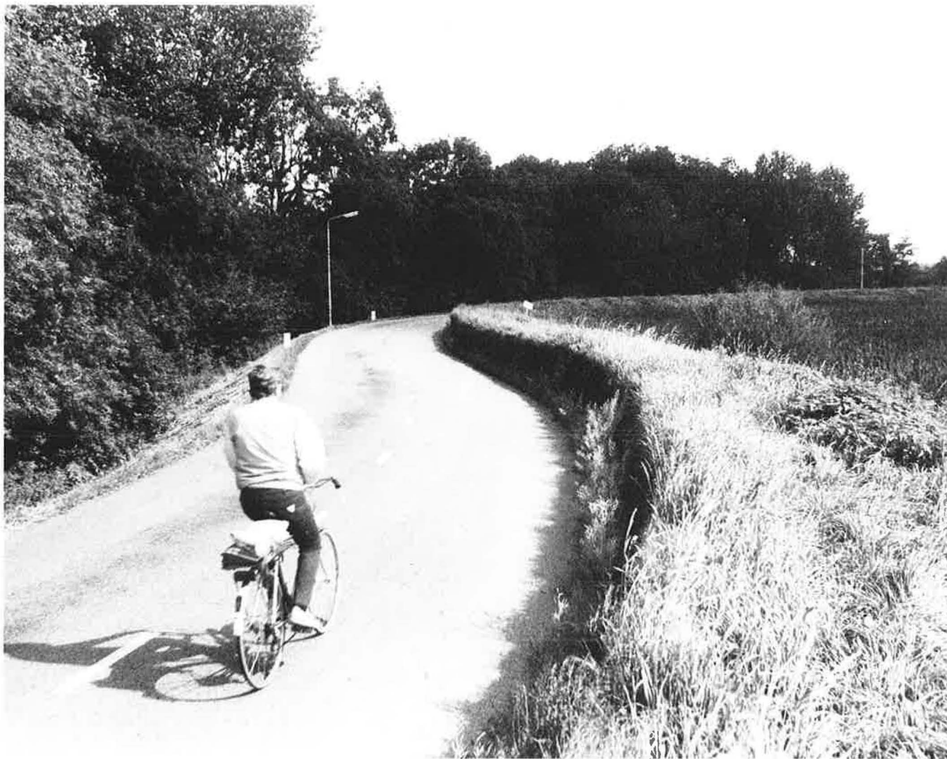
Figuur 23: De dijk tussen Krimpen aan de Lek en Lekkerkerk ter hoogte van de Bakkerswaal. Rechts de Visscherplaat.
