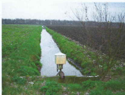
Figuur 2.8 Watervoerend sloot met pomp in laag gelegen deel.
