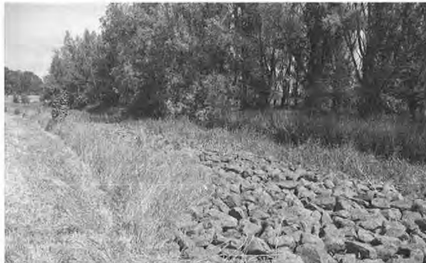
Foto 2.3 Stortsteen en wilgenrij aan de teen van de dijk langs het gors de Buitenlanden
