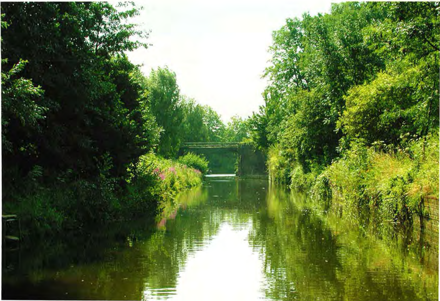
Spoorbrug Lage Fronten
