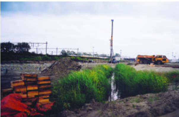
werkzaamheden aan de HSL bij station Lage Zwaluwe
