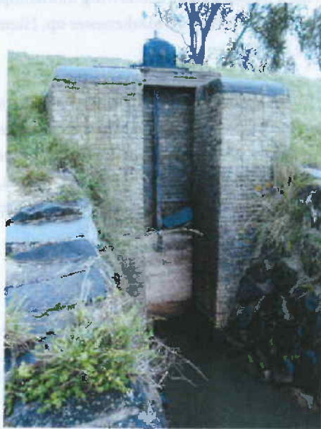
FOTO INLAATDUIKER "DE SPUITER"
