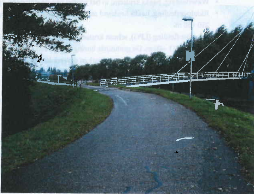
FOTO FIETS/VOETGANGERS- BRUG OVER DE N506
