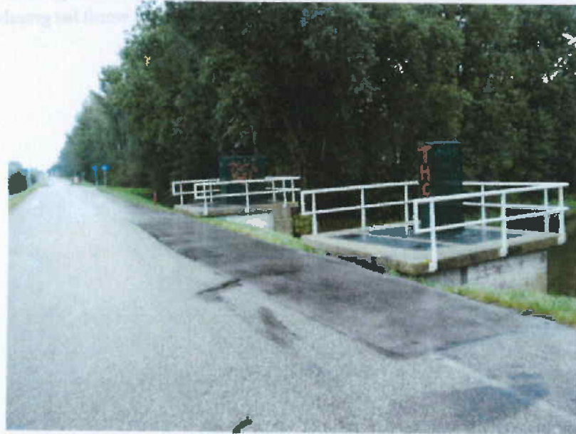
FOTO UITSTROOM- CONSTRUCTIE GEMAAL OOSTERPOLDER
