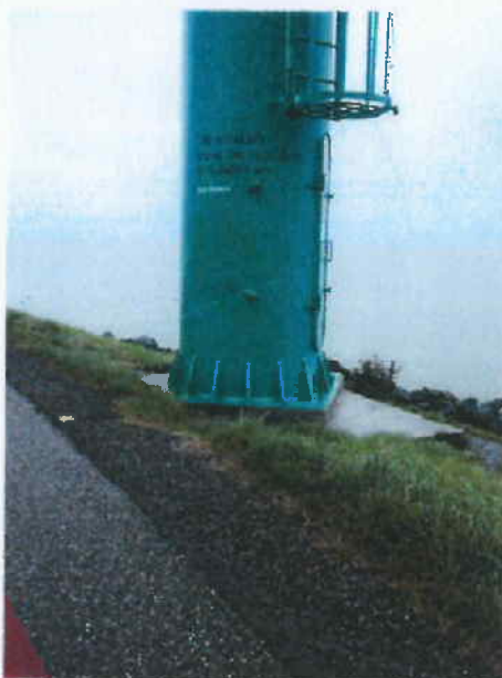
FOTO LICHTOPSTAND MET FUNDATIEBLOK
