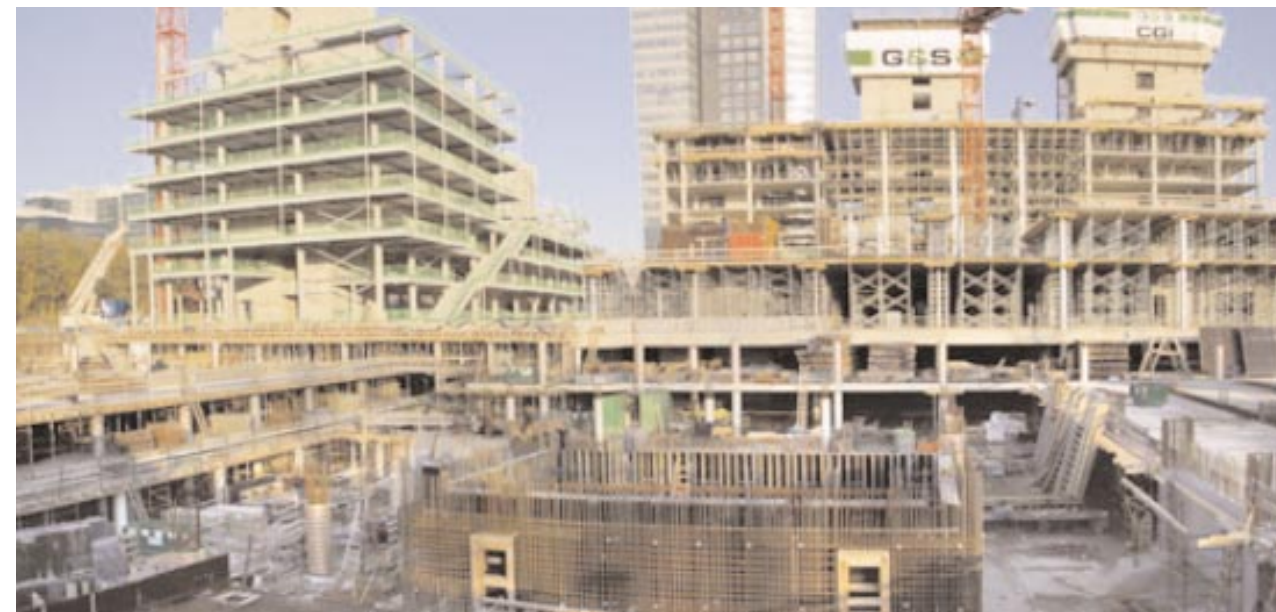
Mahler4 in aanbouw
