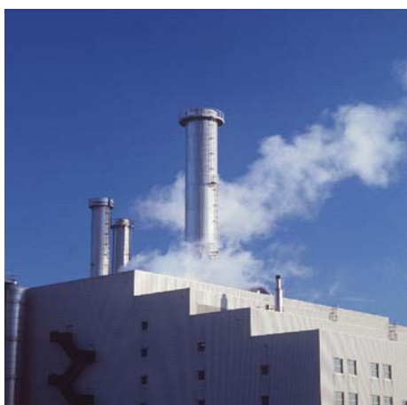
Figuur 13.3: Stadsverwarmingscentrale (STEG)
