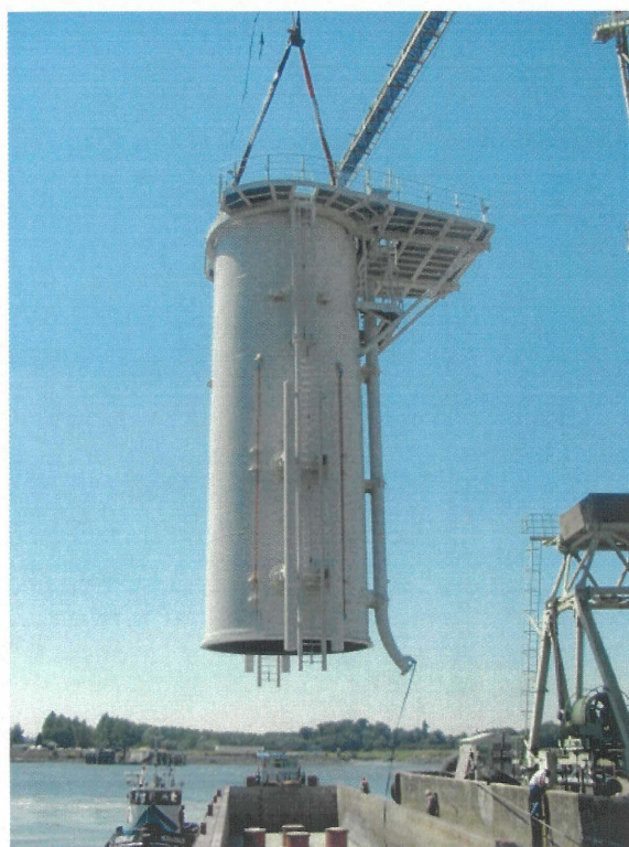
Transitiedeel offshore windturbine (voorbeeld)
