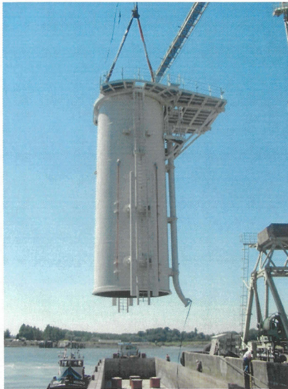
Transitiedeel offshore windturbine (voorbeeld)
